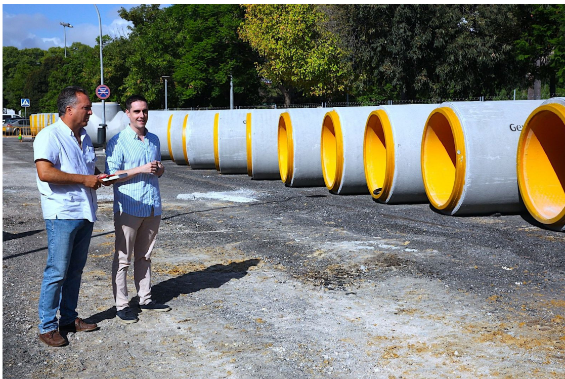
Jaime Espinar, durante la visita a las obras del colector de La Granja en Jerez.
