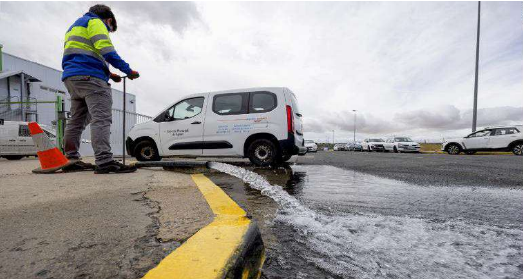
Operario de Aqualia durante el proceso de vaciado de las tuberías en el polígono. / DAVID CASTRO
